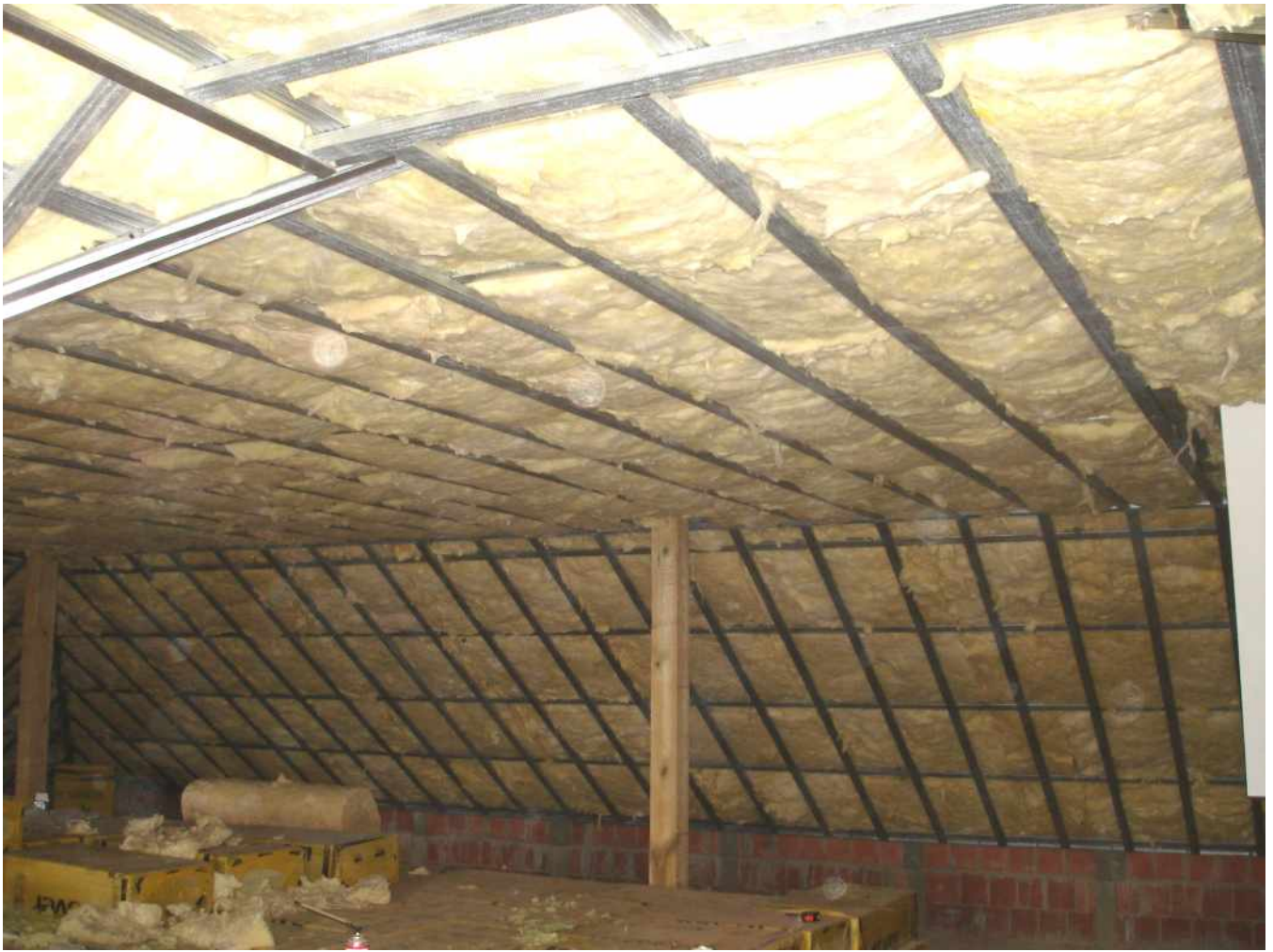
Uzupełnienie docieplenia celulozą Ekofiber między warstwami z wełny mineralnej w połaci dachowej w ilości w/g normy
